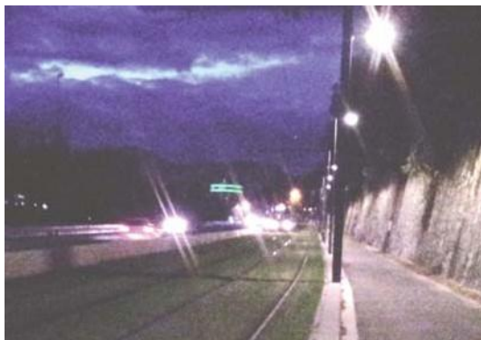
道路上的平行路基位置可能由于缺乏残余或城市照明设备而造成相互目眩问题。还可能惊吓到道路上的汽车，司机不会想到他们的右侧有反向行驶的车辆。
