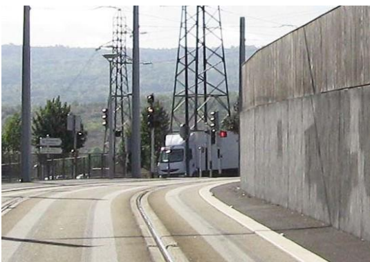
挡土墙遮蔽设于弯道处的信号装备
