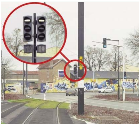
如果只设有一个，信号R17可能被电车电线杆遮蔽
