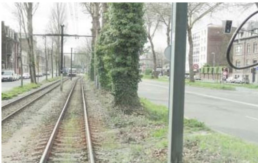
行人“违章”横穿路基时，行道植物阻碍了电车司机的视线
