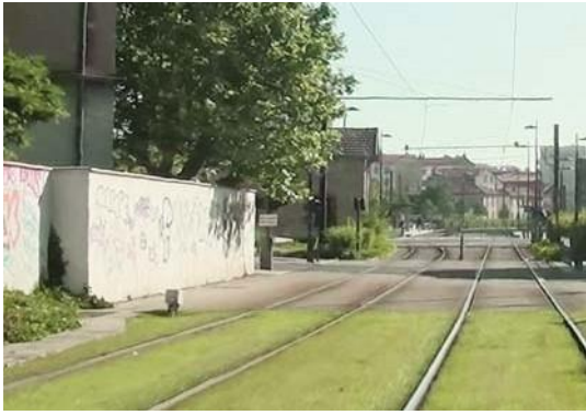
如果汽车在信号R24和移动路障之后停车，路基附近的墙面和烟囱可能阻碍司机视线
