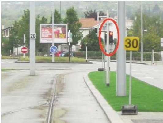
装设在信号R17上游的支架有损该信号的可视性
