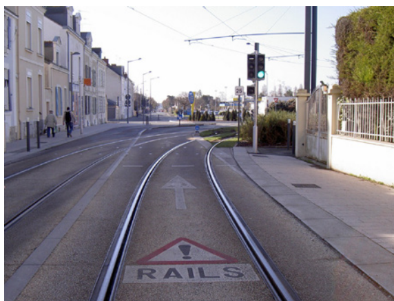
Illustration 8 : Marquage au sol en sortie de site banal à Angers
