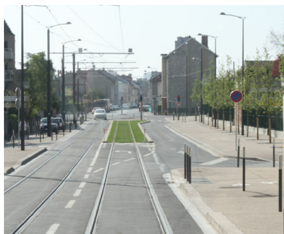
Illustration 31 : Fin de site banal en amont de carrefour à Reims
