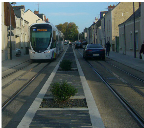
Illustration 25 : Séparateur central pour éviter les dépassements et le demi-tours à Angers
