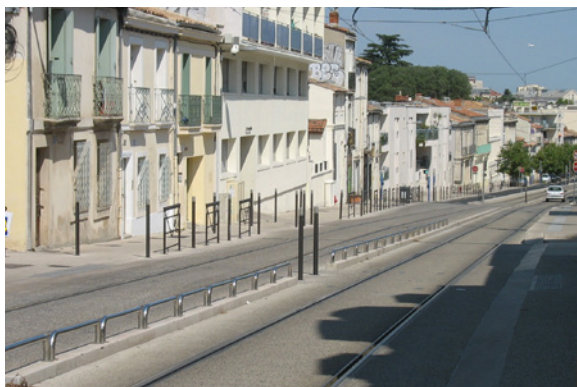
Illustration 3 : Séparateurs en amont d'une station à quais décalés à Montpellier
