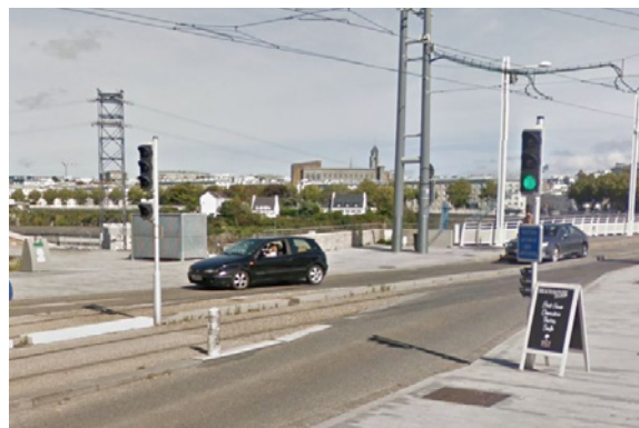
Illustration 12 : Entrée du site banal à Brest gérée par feux R11v
