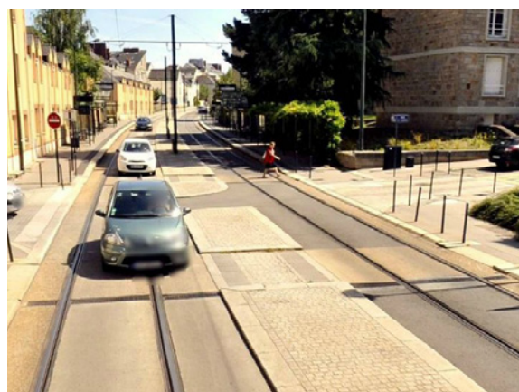
Illustration 28 : Refuge pour traversée piétonne à Nantes
