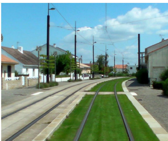
Illustration 24 : Identification de la voie en site propre par du gazon à Nantes
