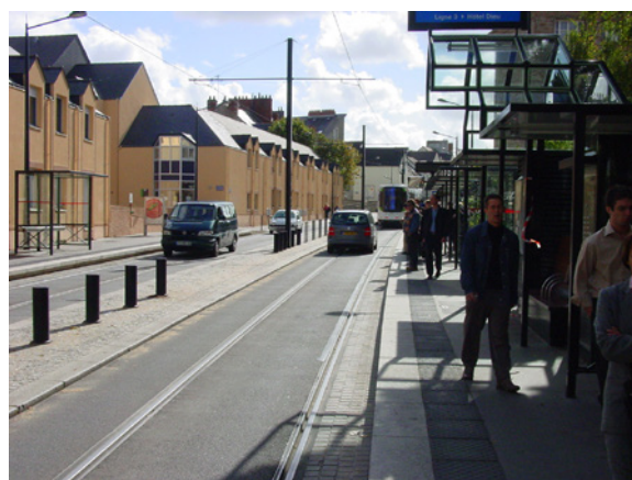
Illustration 33 : Station à quais face à face à Nantes
