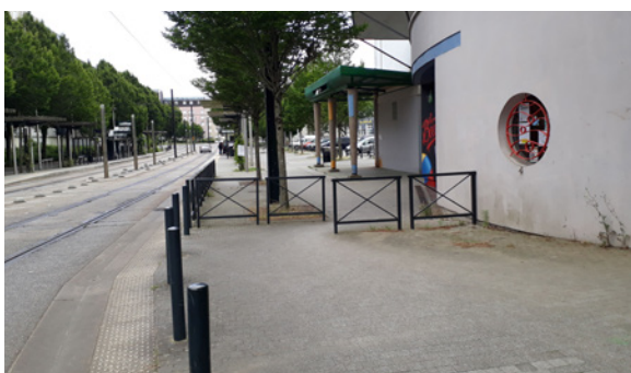
Illustration 11 : Barrières en entrée de station pour dissuader les deux-roues motorisés ou non à Nantes
