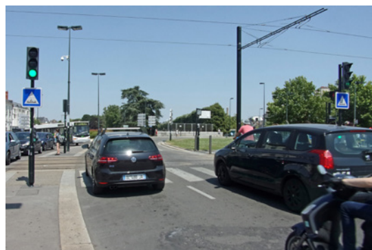
Photo 20 : répétition des signaux sur une traversée de branche de giratoire (source Cerema)
