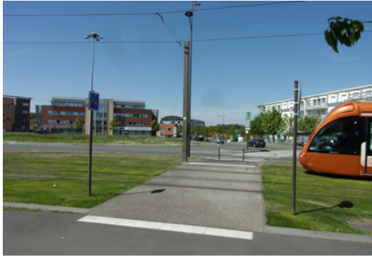
Photo 7 : traversée piétonne de site latéral à proximité d'un giratoire (source : Cerema)
