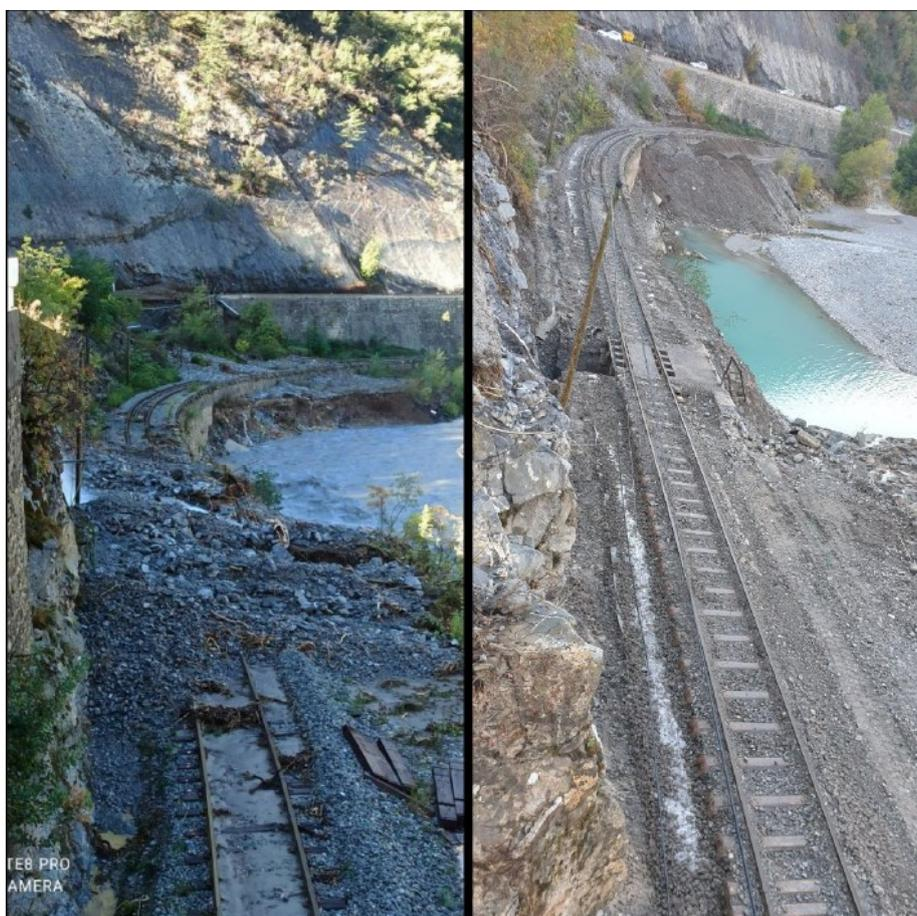
*Figure 13: Exemple d'éboulement suite au passage de la tempête Alex le 02/10/2020 sur la ligne des Chemins de Fer de Provence // Source: RRT PACA*
