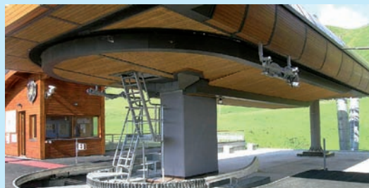
Station "ouverte" de Chamrousse (source CETE de Lyon)
