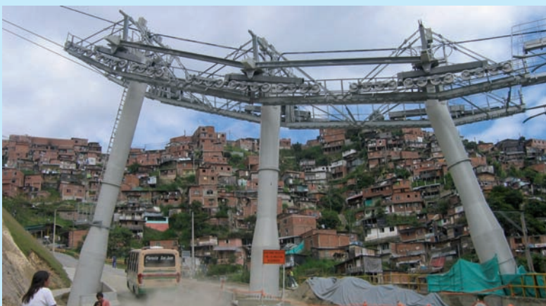
Pylônes des télécabines de Medellín – Crédit photo : Pomagalski
