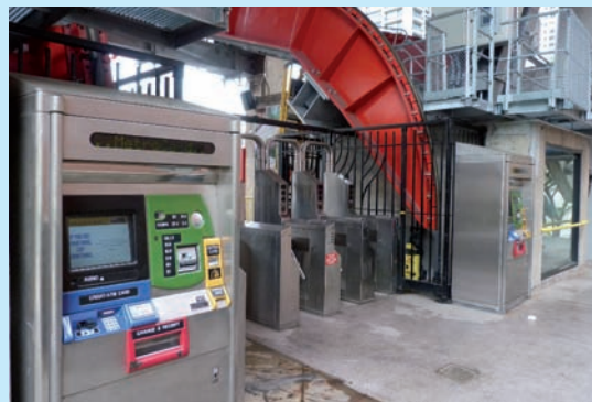
Distributeur de la carte « MetroCard » et portillons d'accès en station du téléphérique de New York – Crédit photo : CETE de Lyon
