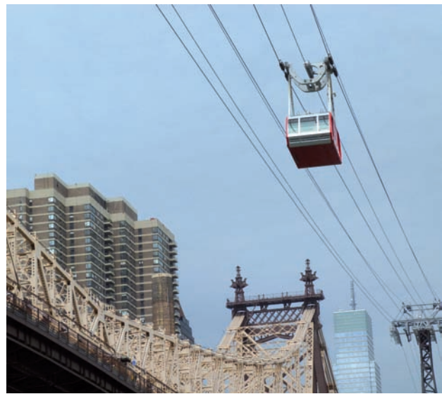
Téléphérique de New York – Crédit photo : CETE de Lyon
