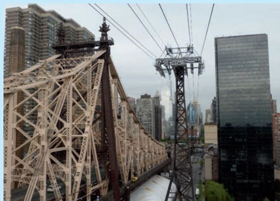
Pylône du téléphérique de New York – Crédit photo : CETE de Lyon
