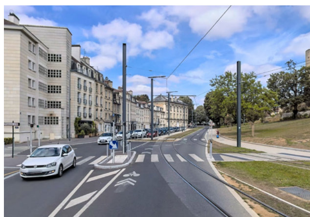
Voie de tramway en site propre interrompant une voie routière (Caen, ©Plans)
