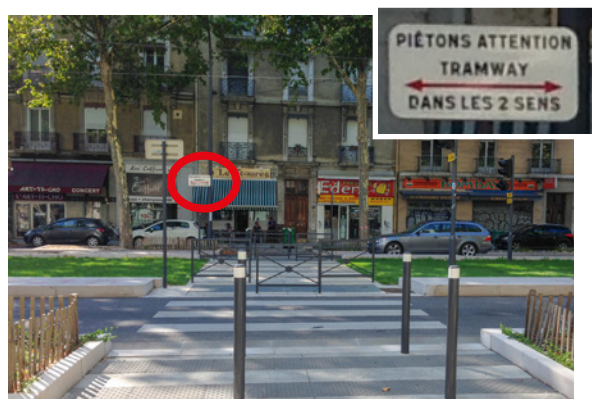
Traversée de voies tramways aménagées pour les piétons où le panneau mentionnant « Attention tramway dans les deux sens » est implanté en aval de la traversée (Grenoble, source : STRMTG)
