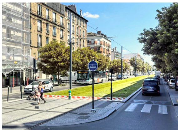
Différenciation des espaces à traverser par le revêtement et le marquage (Paris, ©Plans)
