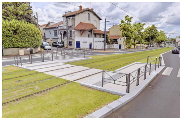
Aménagement en baïonnette d'une traversée de la plateforme tramway aménagée pour les piétons (Lyon, ©Plans)
