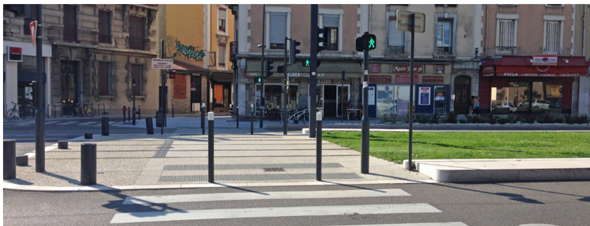
Traversée en 1 temps : la signalisation lumineuse des voies routières et de la plateforme tramway est coordonnée (Grenoble, source : STRMTG)
