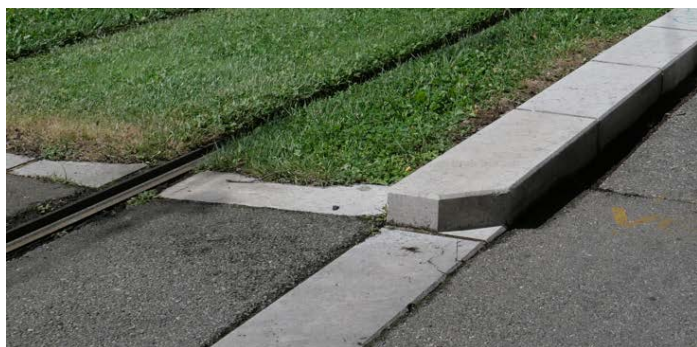
Bordurage d'amorce. (Source : Cerema)
