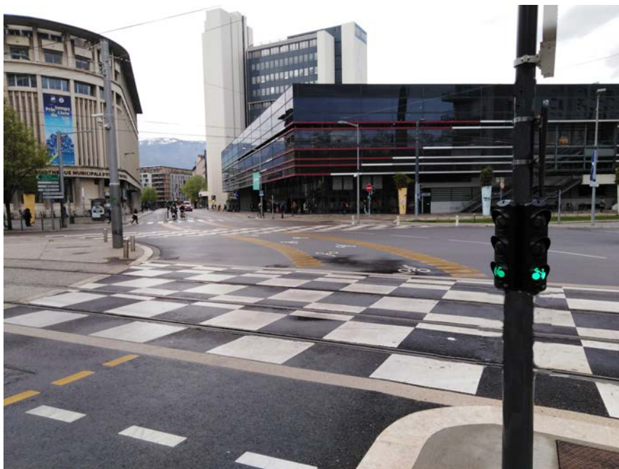
Dans ce carrefour complexe et de taille importante fortement circulé à la fois par les vélos et par les véhicules motorisés, une traversée en un seul temps a été mise en place pour les cyclistes, avec emploi d'un feu R13c. (Source : Grenoble Alpes Métropole)
