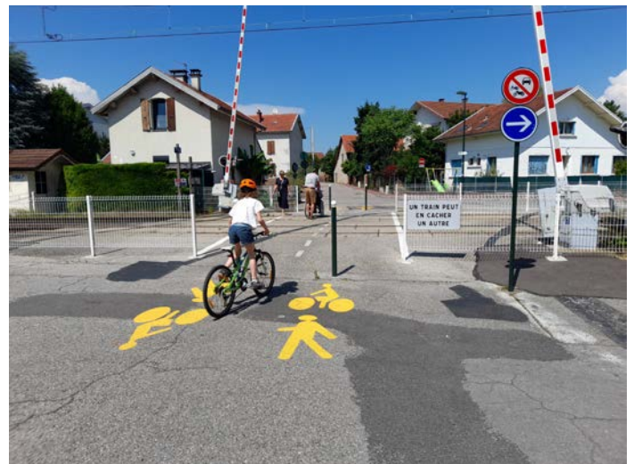
Exemple de passage à niveau (train) dédié uniquement aux cyclistes et piétons. (Source : Cerema)
