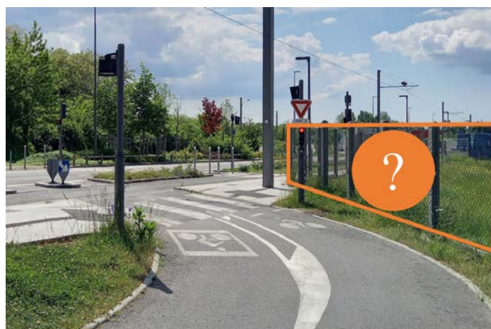
Recherche d'orthogonalité et retrait des masques à la visibilité : deux objectifs prioritaires lors de l'aménagement des intersections vélos-tramways. (Source : Métropole de Bordeaux)
