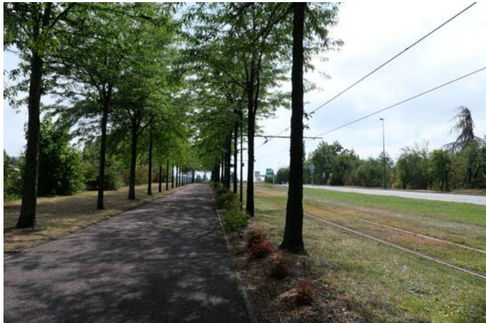
En section courante, la perception du tramway par les cyclistes peut être assurée par la nature ajourée de la séparation, et la présence de la ligne aérienne de contact. (Source : Cerema)
