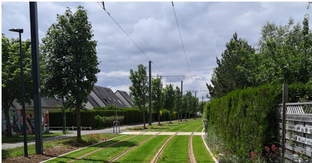
Tramway circulant à Caen, avec un masque à la visibilité (source : STRMTG)
