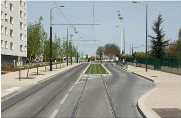
Ilustración 14: Salida de la plataforma compartida con desvío de la circulación general en Reims
