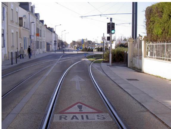
Ilustración 8: Pintura en el suelo a la salida de plataforma compartida en Angers
