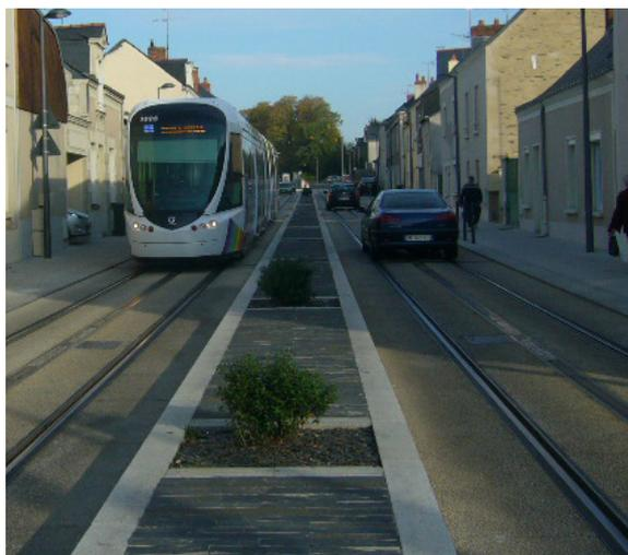
Ilustración 25: Separador central para evitar los adelantamientos y los giros en redondo en Angers
