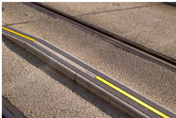
Ilustración 7: Separador implantado entre la plataforma compartida y plataforma reservada en Angers
