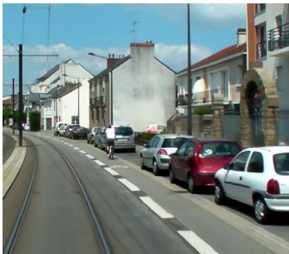
Ilustración 26: Plataforma compartida con carril bici en Nantes
