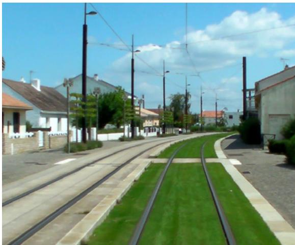
Ilustración 24: Identificación de la vía en plataforma reservada mediante césped en Nantes
