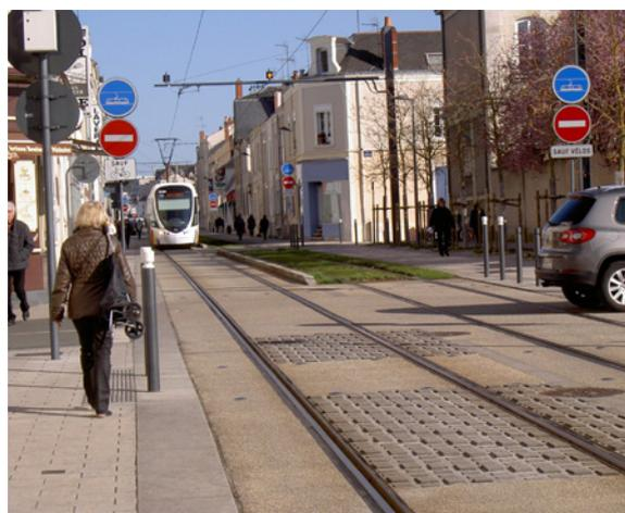
Ilustración 30: Fin de plataforma compartida en Angers con cambio de revestimiento
