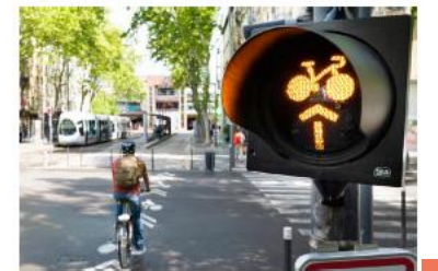
Exemple d'utilisation du signal R19 allumé en phase tramway. (Source : Thierry Fournier – Métropole de Lyon)
